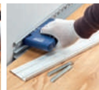
Na zszywki Installation with staples Hefiklammerbefestigung
